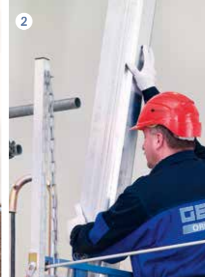
2 Hliníkové sloupy mohou být sestavovány pouze jednou osobou.
