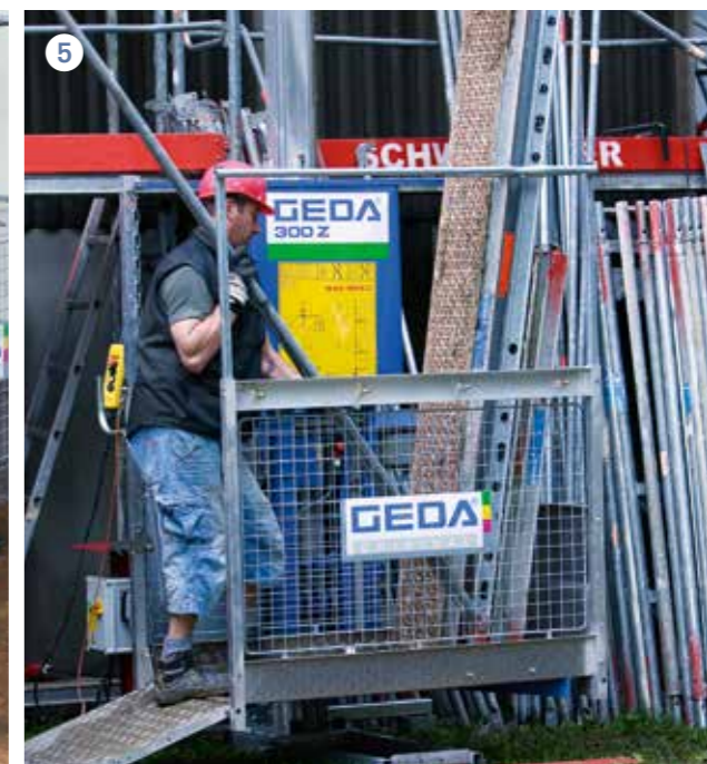
5 Držák lešenářských dílů umožňuje bezpečný transport.
